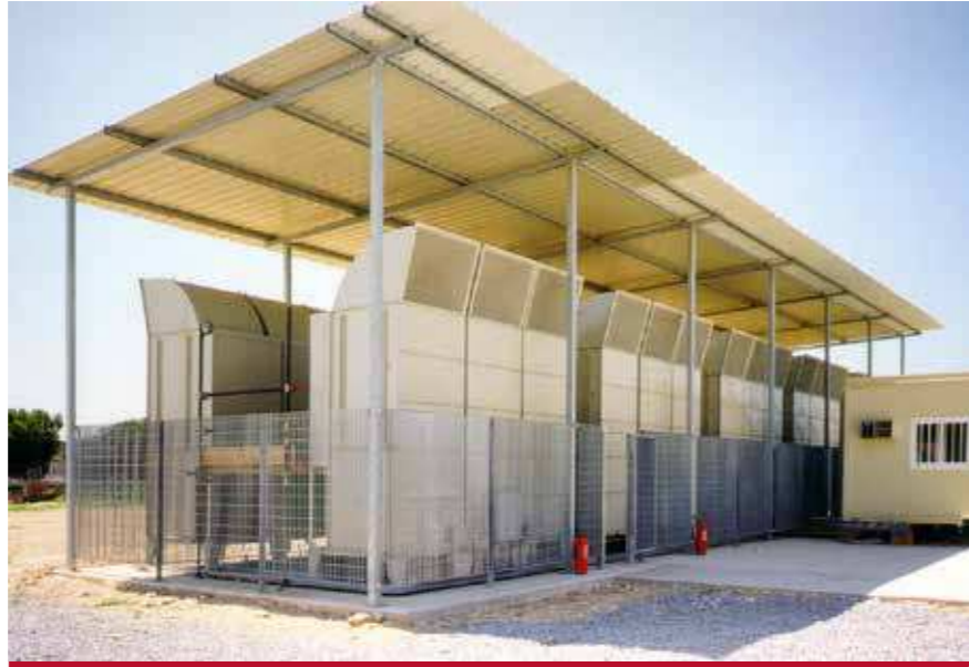
Resistenze di carico - Media Tensione
